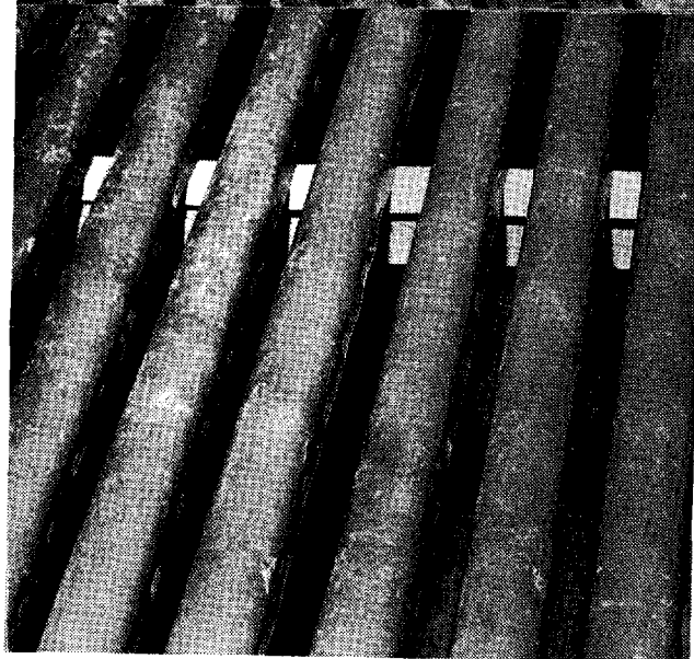
Hældende tremmegulv. Fremstillet af 5 cm bredt brædt med 2,5 cm mellem brædderne. Brædderne beslået med 1 mm tyk blød plast, - imellem trætræmmen og plast 5 mm skumgummi.
