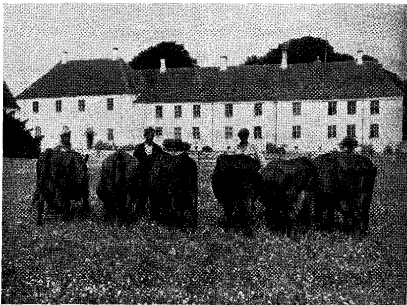
6 forsøgskøer med Wedellsborg hovedbygning i baggrunden.
