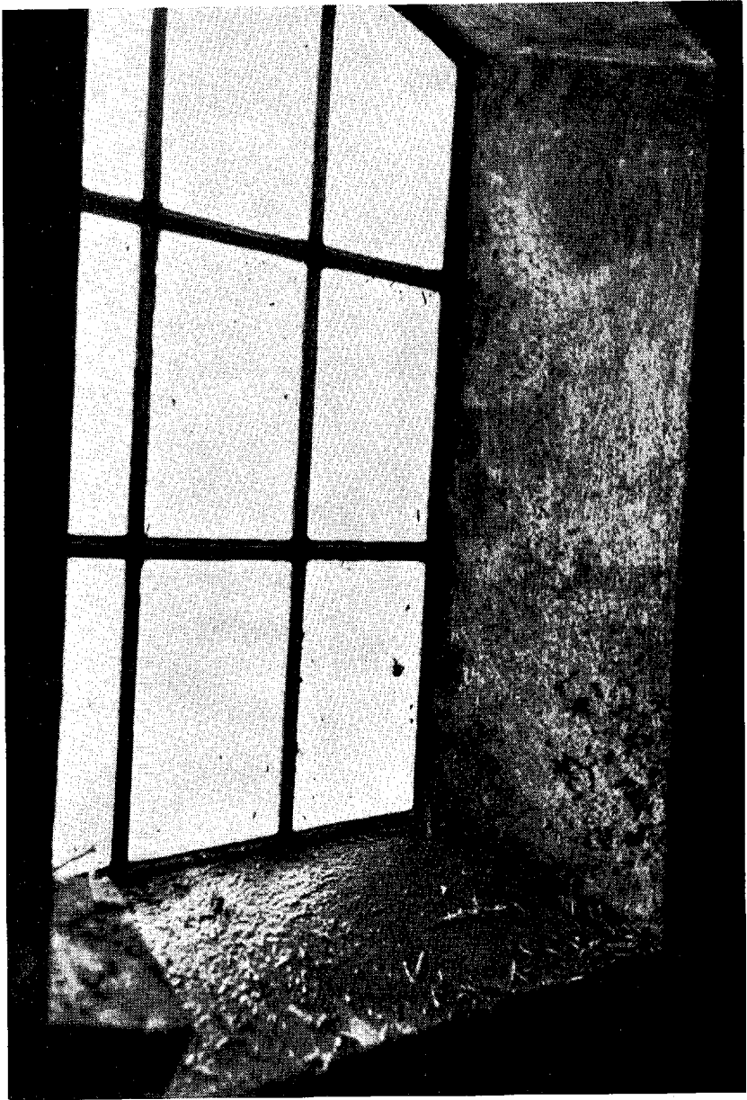
Fig. 8. I den kolde Tid driver en Strøm af Vand ned ad det enkelte Vindue, siver ned i Murværket, der tæres og frostsprænges. Stenen til venstre har efter kun 10 Aars Forløb helt løsnet sig. (Fot. Winclair.)
