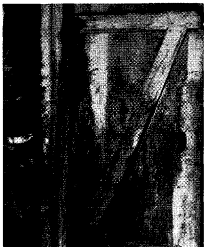
Fig. 48. Faa cm fra Dyrets Forparti er Staldluftens Temperatur, som det fremgaar af den permanente Rimdannelse paa Døren — (der fører fra Fodergang ud til Foderlo) — under 0^{\circ} C. Mangelfuld Isolation. Bygget 1922. (Fot. Reinh. Jensen).
