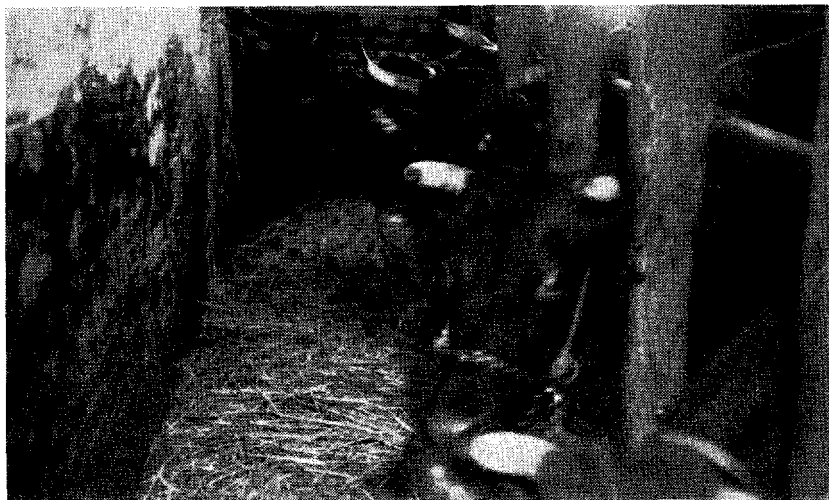
Fig. 26. Fra Dyrets Forparti afgives betydelige Varmemængder ved Straaling til den kolde og vaade Halvstensmur, der vender ud til Laden. Mangelfuld Varmeisolation. Bygget 1922. (Fot. Reinholt Jensen.)
