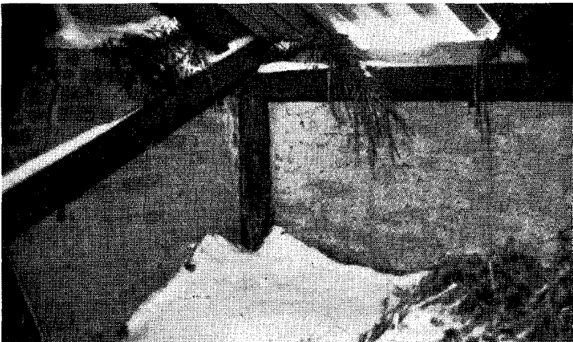
Fig. 70. Foruden at afkøle Stalden nedenunder bevirker det utætte Tag, at Fugt angriber Foder og Træværk. Bygget 1922. (Fot. Reinholt Jensen.)
