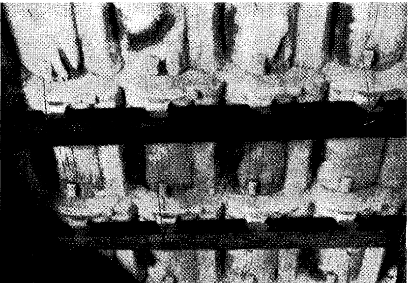
Fig. 72. Daarligh ventileret Stald: Emmen trænger op paa Loft, fortætter sig og fryser til Rim, som ved Tøvejr eller Solskin smelter og drypper ned paa Foderet. Bygget 1937. Stalden bør isoleres, saa effektiv Ventilation muliggøres. (Fot. Winclair.)
