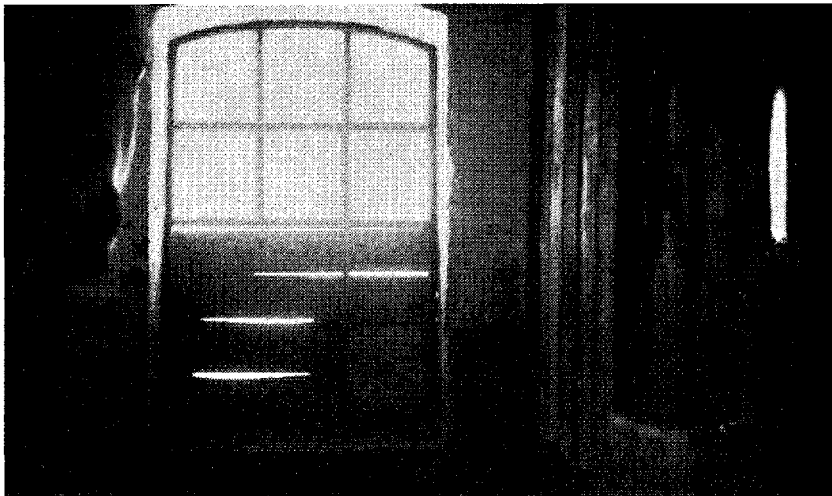
Fig. 39. En fornylig indkøbt Avlshingst til 5000 Kr. har som Værn mod Frostvinteren dette sønderbrudte og utætte Støbejernsvindue. Bygget 1922. (Fot. Reinholt Jensen.)
