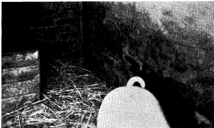
Fig. 50. De kolde Vægge i denne Baas drev af Fugtighed. Hul-Ydermur af 29 cm Kalksandsten er for kold til en Husmandsstald, bør isoleres f. Eks. ved løse Storklinker i Hulrum. Bygget 1922. (Fot. Reinholt Jensen.)
