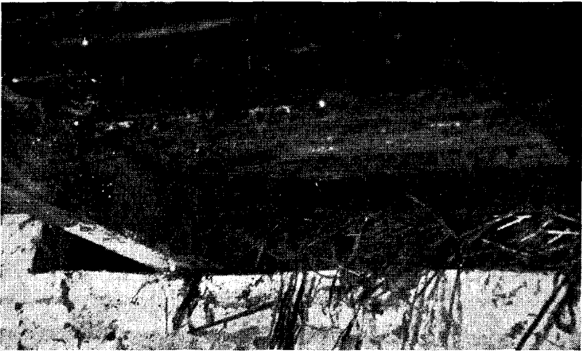
Fig. 61. Forraadnelsen er begyndt i dette 10 Aar gamle Roehusloft, og den fremskyndes ved de 2 Aabninger i Skillerum mod Hestestald, ad hvilke ogsaa fra Hestestalden varm og fugtig Luft søger ind i og giver Fugtighed i Roehus. (Fot. Winclair.)
