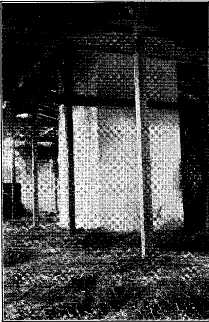
Fig. 35. Træskorsten — indvendig og udvendig pudset.
