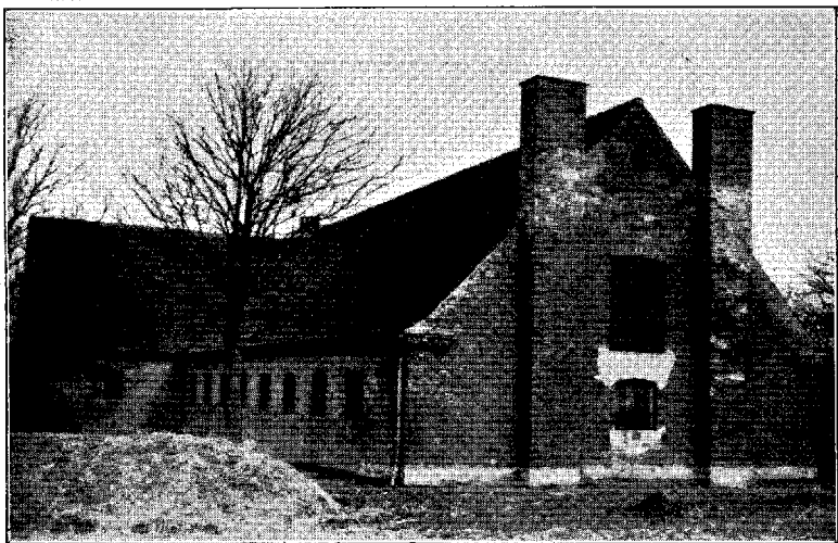
Fig. 33. Murede Skorstene paa Forsøgsstationen »Høng« — i 1936 erstattet af »Roar-B«-Anlæg, da Skorstenene havde vist sig mindre hensigtsmæssige.
