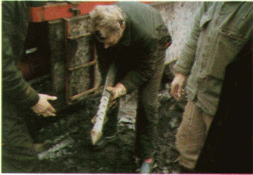
Fig. 2. Rammespidsen påmonteres et rør.
