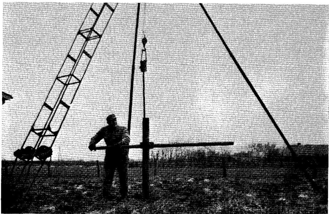
Fig. 1. Boreudstyret i arbejde. Drilling equipment at work.
