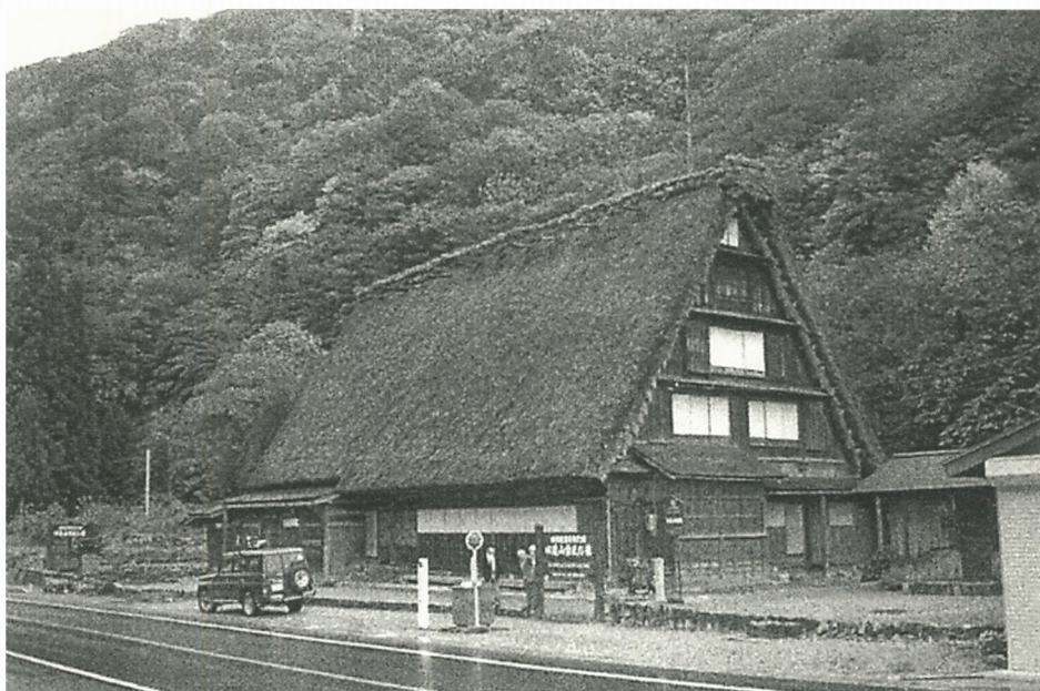
Fig. 19 Hus med permanent brandsprøjte. House with permanent installed waterguns
