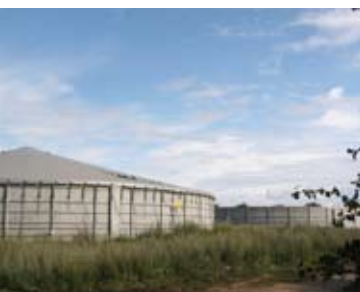
Overdækning af gyllebeholdere reducerer tab af ammoniak. Foto: DJF
