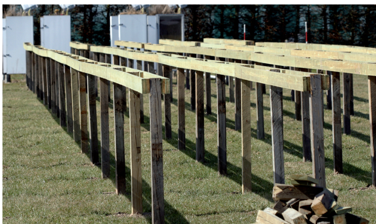
Jordbærstativ - Konstruktion: Eksempel på enkel konstruktion af tabeltop-system med trykimprægneret træ.
