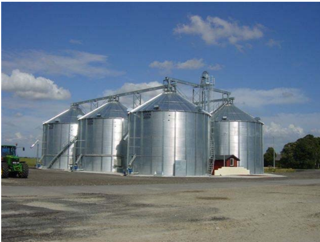
Figur 26. Stålsiloer findes i mange størrelser og typer. De anvendes som enkeltsiloer til lagring, evt. med beluftning, samt i store siloanlæg, hvor en eller flere siloer er med tørring (koldluft eller med høj temperatur), mens andre anvendes til lagring
