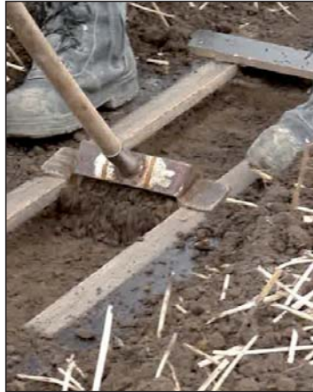
Foto 3. Med en specialfremstillet 'høvl' understøttet af en skabelon lavet af støbekrydsfinerplade blev der lavet en grube nøjagtig svarende til målesystemets dimensioner.
