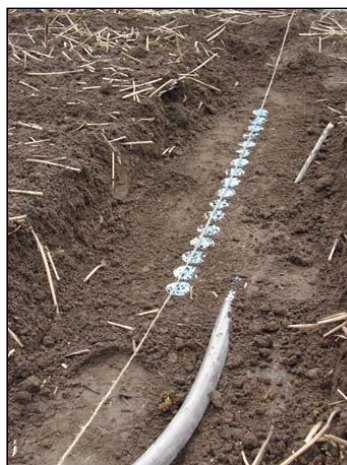
Foto 8. Installation af transducersystem. Venstre: skabelon til høvl for grube. Højre: Transducer- systemet nedlagt, mangler kun løs jord. Installation of transducer system.
