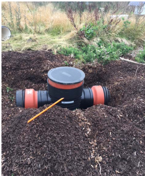
Figur 16. Gennemløbsbrønde anvendt som spulebrønde ved to anlæg. Under etablering (tv.), efter etablering (th.) (Kilde: Dan Jord).
