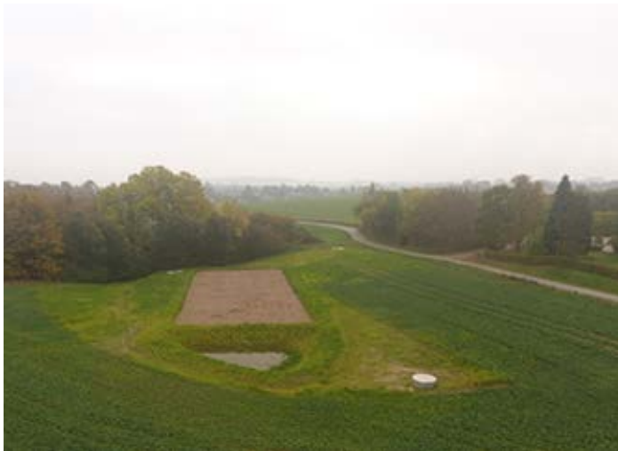
Figur 26. AU's filtermatrice anlæg ved Dundelum ved Haderslev med fordelerbrønd (blank låg kan ses nederst til højre), sedimentationsbassin og bassin med træflis (Kilde: SEGES)
