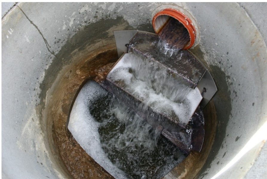
Figur 20. Geniltningstrappe til supplement af primær geniltning (Kilde: AGRO, AU).
