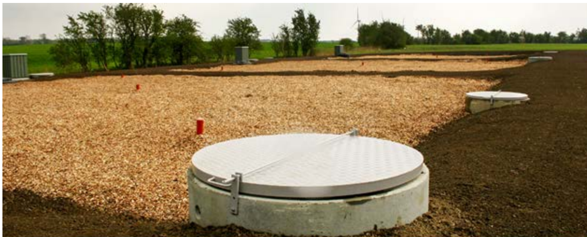
Figur 32. AU's anlæg ved Gyldenholm ved Slagelse med de 3 flisbassiner og indløbsbrønde til højre i billedet (Kilde: AGRO, AU).
