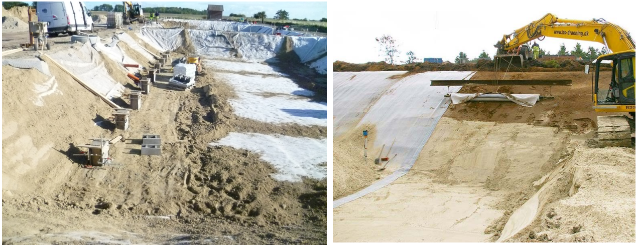
Figur 14. Udlægning af bentonitmembran. Endvidere vist (foto til venstre) støbte sokler som anlæg for hovedbassindrænrør (Kilde: Foto til venstre BM Bogense, til højre Google).
