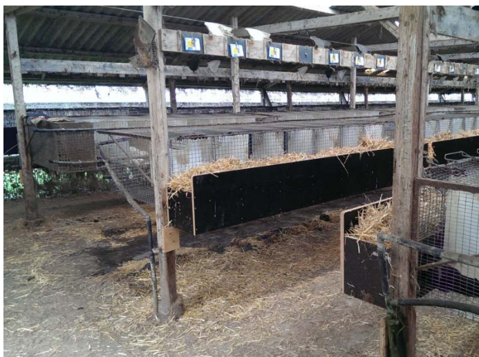
Figur 8.34. Foto af minkhal med støbt gulv under burene (Kilde: Marianne H. Hansen, Brønderslev Kommune).
