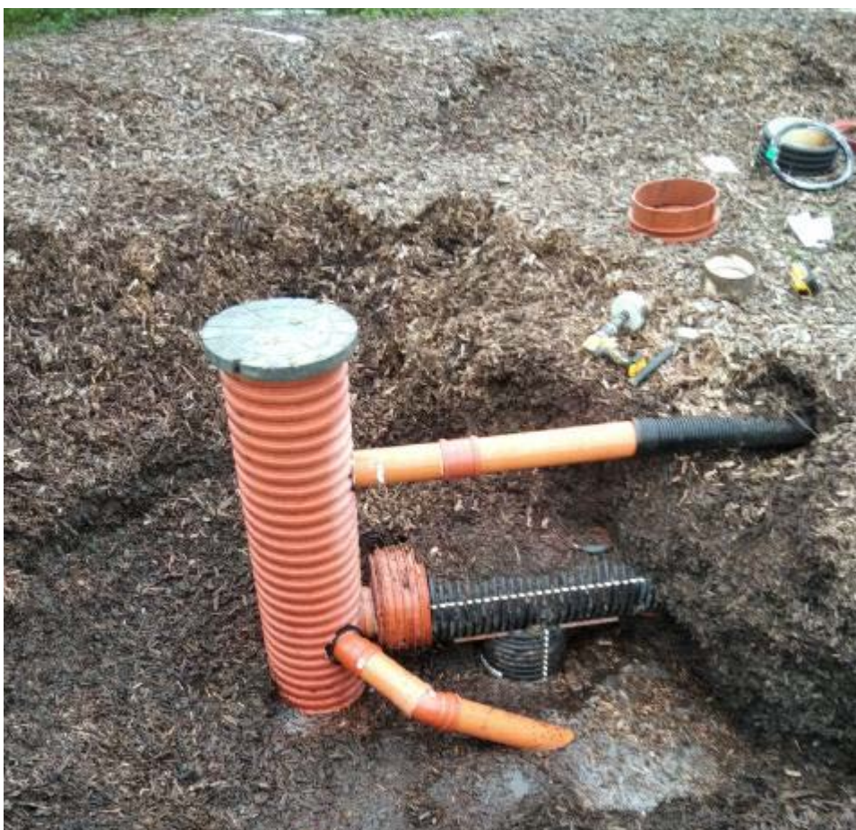
Figur 17. Etablering af spulebrønd i bassin med våd flis dybere end 1 m. og derfor drænrør både over og under bassindrænrøret (Kilde: BM Bogense).
