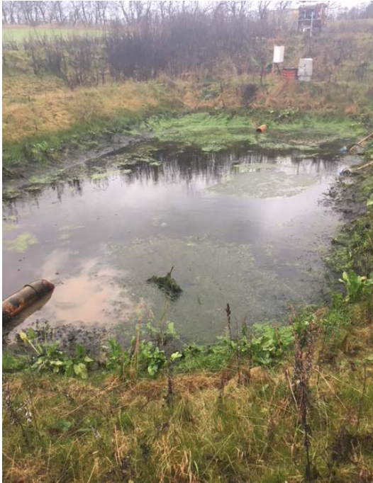
Figur 15. Algevækst i sedimentationsbassin (tv.). Tilstopning af bassindrænrør med alger fra sedimentationsbassinet (th.) (Kilde: Dan Jord).
