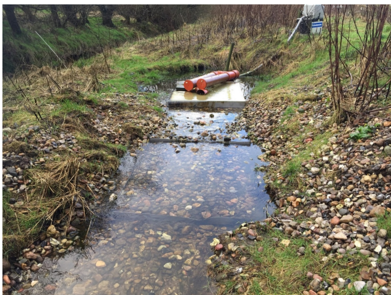
Figur 22. Geniltning i fladt terræn. Her ses de flade trappetrin med et enkelt lag sten, der medvirker til at skabe turbulens i vandet, hvorved geniltningen øges (Kilde: Bioscience, AU).
