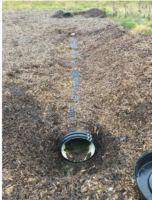
Figur 15. Algevækst i sedimentationsbassin (tv.). Tilstopning af bassindrænrør med alger fra sedimentationsbassinet (th.) (Kilde: Dan Jord).
