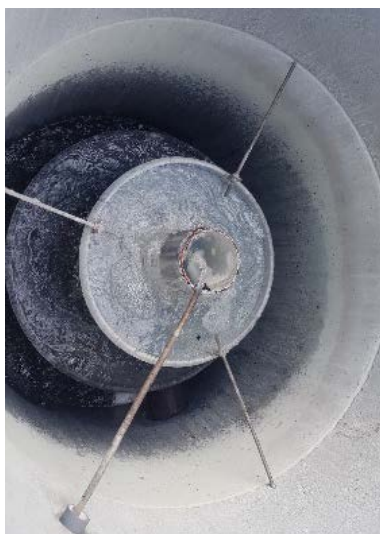
Figur 19. Foto af geniltningstrappe i geniltningsbrønd (Kilde: WSP).
