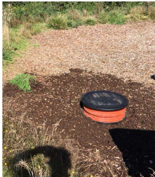
Figur 16. Gennemløbsbrønde anvendt som spulebrønde ved to anlæg. Under etablering (tv.), efter etablering (th.) (Kilde: Dan Jord).
