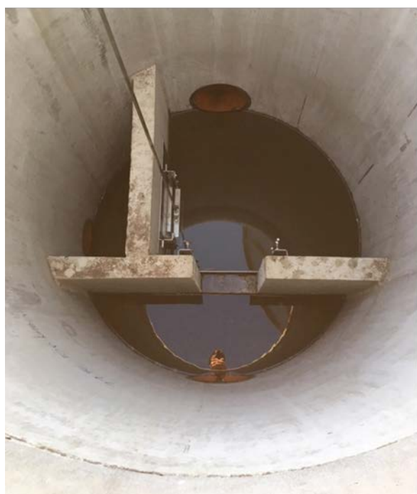
Figur 7 Billede (tv.) og skitse (th.) af fordelerbrønden ved AU's anlæg ved Egsmarken på Fyn med rørføring, regulerbart overløb og spjæld, så anlægget kan lukkes om sommeren. Overkant af rør mod sedimentationsbrønd eller bassin skal være i samme kote som underkant hoveddræn (Kilde: Foto fra AGRO, AU, Skitse fra WSP).
