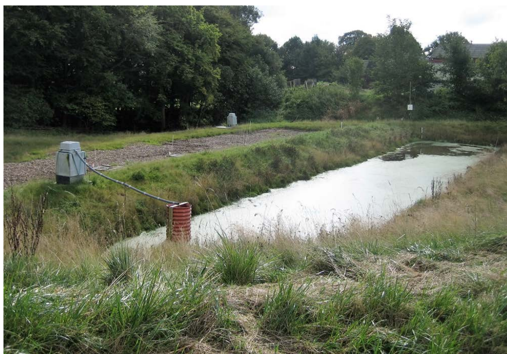
Figur 29. Foto af minivådområde med stuvningsbassin/sedimentationsbassin. Forrest i billedet ses det store vertikalt stillede perforerede rør, der passivt styrer vandstanden i forbassinet (Kilde: Bioscience, AU).
